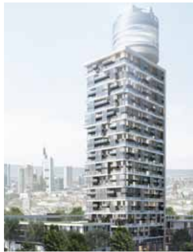
Meixner Schlüter Wendt Architekten: Wohnhochhaus Henninger Turm, 2014–2016 \ © Meixner Schlüter Wendt Architekten
